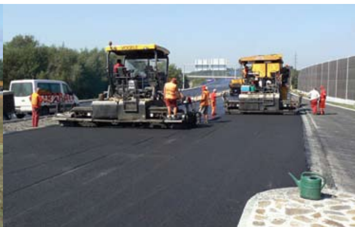
Pokládka obrusné vrstvy v km 2,900
