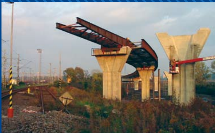
Most přes železniční trať – montáž ocelové konstrukce
