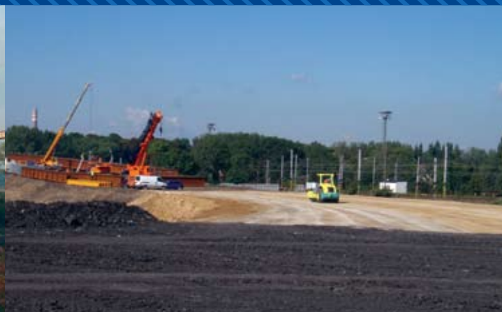
Úprava pláni před mostem přes železniční trať
