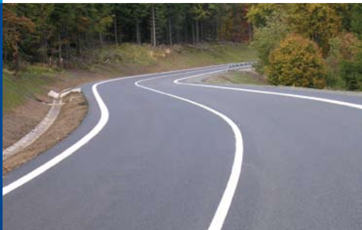
Dokončená rekonstrukce silnice v km 9,300
