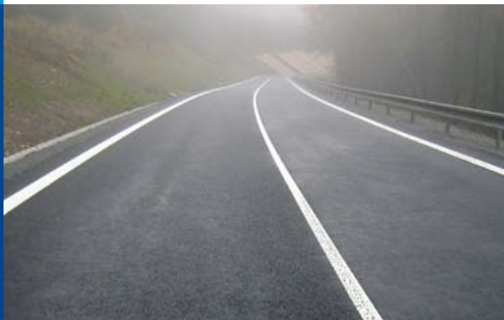
Dokončená rekonstrukce silnice včetně vodorovného dopravního značení
