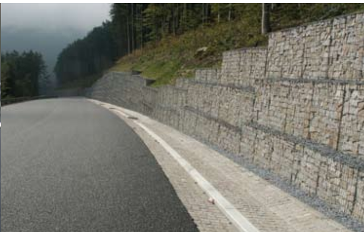
Dokončená gabionová zeď v km 11,781-12,048
