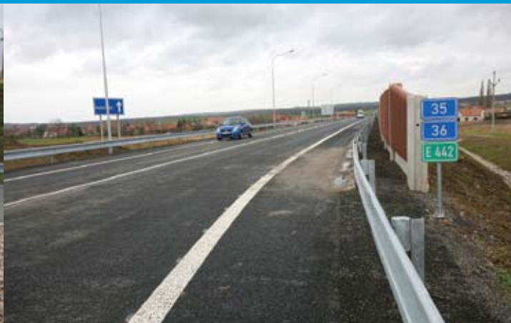
Začátek protihlukové stěny na ochranu blízké zástavby v km 1,40
