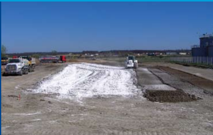
Vápnění podloží násypu v km 0,82-0,92
