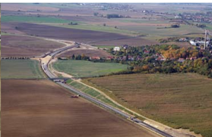
Pohled přes železniční most na trasu obchvatu, ve směru na Hradec Králové
