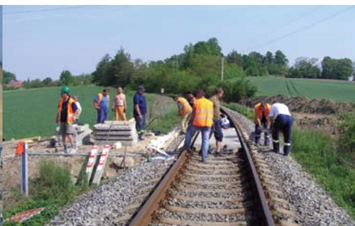
Budování provizorního přejezdu železniční tratě
