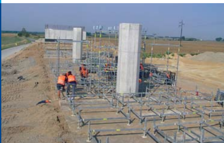
Montáž podsádkružení nosné konstrukce nadjezdu silnice III/32257
