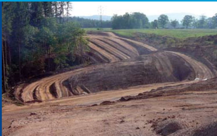
zemní práce na hlavní trase v km 3,0
