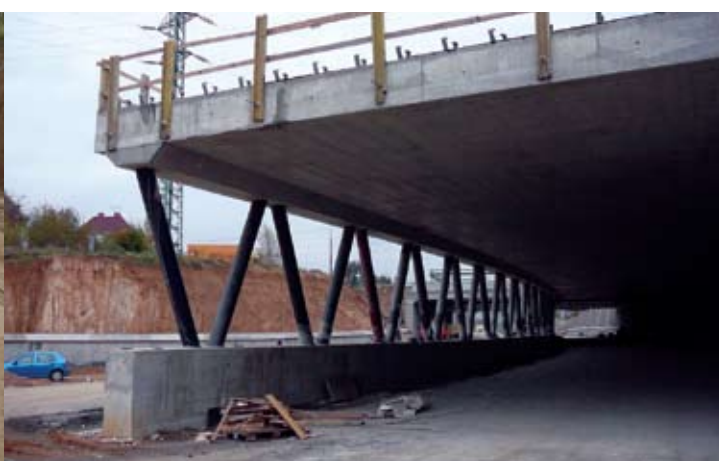
galerie mostu pod tramvajovou trať
