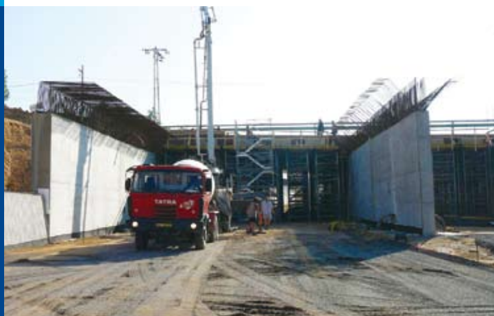
spodní stavba mostu pod tram. trať
